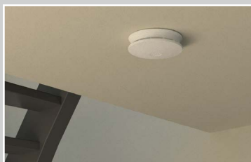
Požární hlásiče
