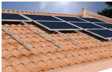
Upevnění na šikmou střechu s vlnitou krytinou
