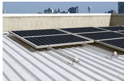
Instalace na trapézové plechy
