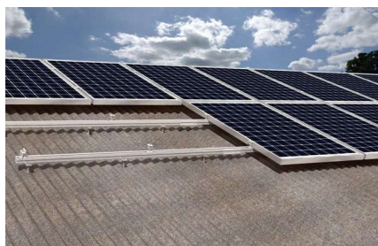
Instalace solárních panelů na šikmé střechy s vlnitou krytinou
